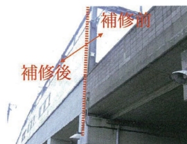
●既設高欄の改修 (表面保護) 築後約 30 年が経過し経年劣化した高欄の劣化進行抑制と機能回復対策として本工法を適用しました。 施工面積: 約 390 m 2 工期: 2008/4 ~ 2008/7
