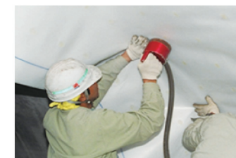
磁気誘導機によるシート固定
