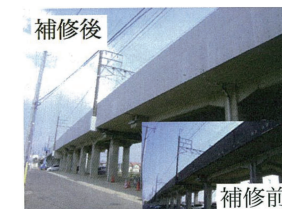
●既設高欄の改良 (高欄高上げ+表面保護) 高欄の高上げ工事に本工法を適用しました。高上げの目的は列車の高速化にともなう騒音対策です。 施工延長: 約 2,900m 工期: 2008/12 ~ 2009/9
