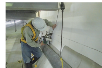
自動溶接機によるシート重ね合わせ溶着
