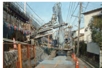
大径補強材の打設状況
