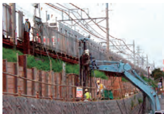
鉛直抑止杭の施工状況
