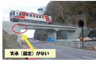
補強盛土 (GRS) 一体橋梁
