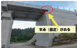
耐震性 (GRS) 橋台
