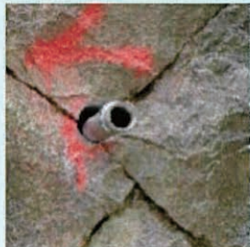
②注入ボルト打設
