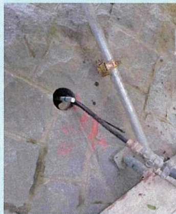
⑤補強材定着材の注入
