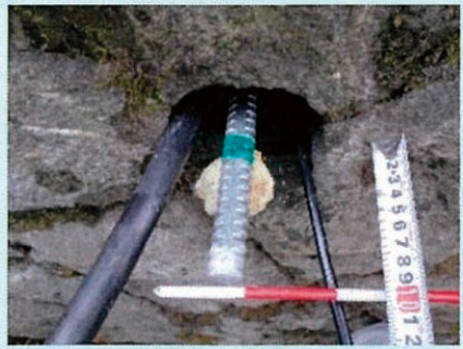
⑥補強材の挿入
