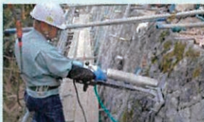
④補強材打設孔の削孔
