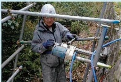
①注入ボルト打設孔の削孔
