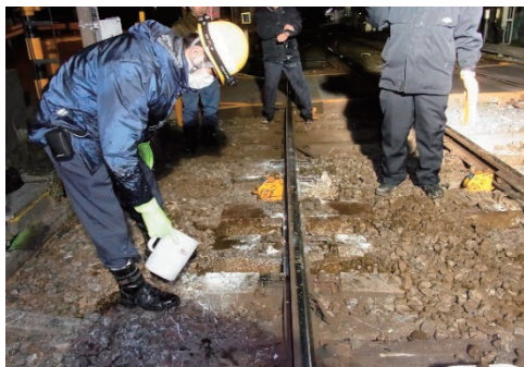
噴泥対策工事の施工に関する現地調査
