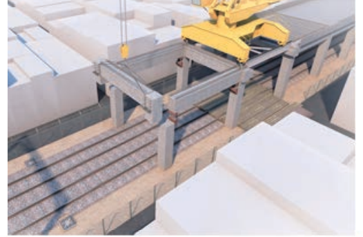
トラベラークレーンによる施工
