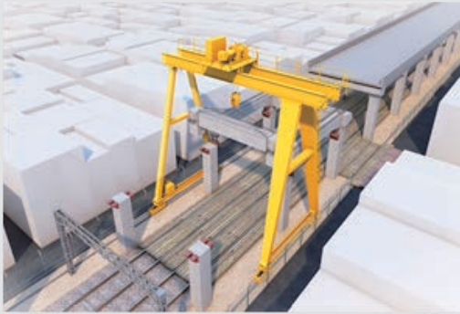
門形クレーンによる施工
