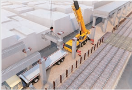
移動式クレーンによる施工
