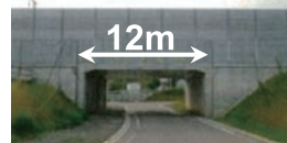
中学校線架道橋 RC単版桁
