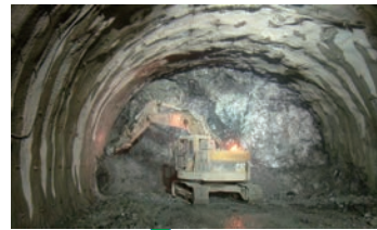
トンネル建設 工事等
