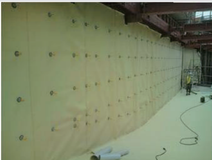
開削 トンネル
