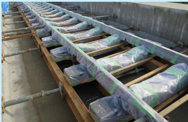
型枠の構築状況
