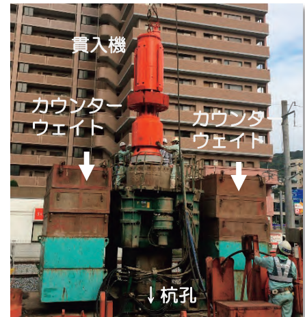
履歴荷重の載荷状況
