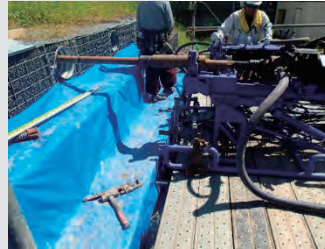
⑤地山補強土工
