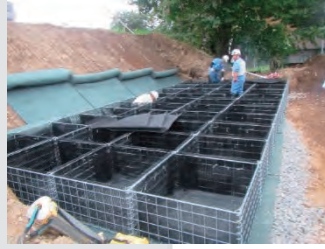
②かご枠組立て
