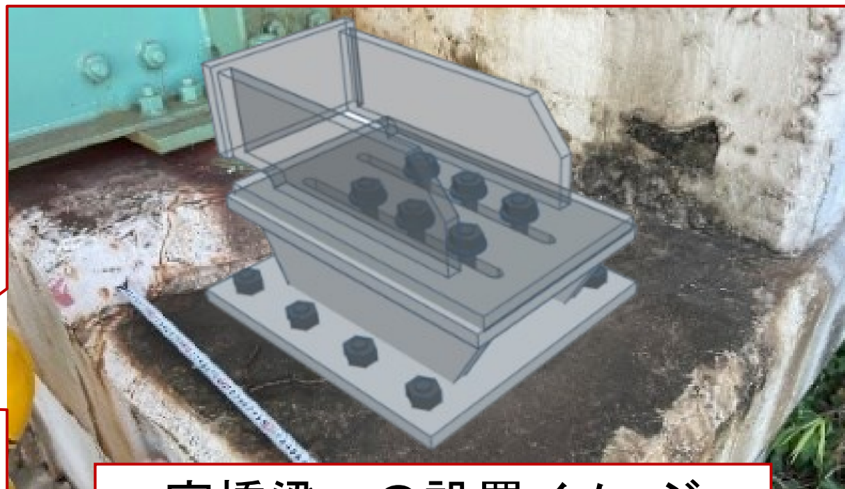
実橋梁への設置イメージ
