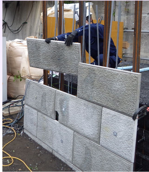
②埋設型枠設置
