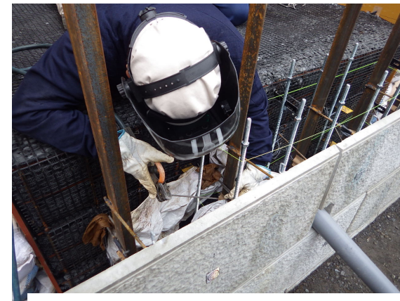
⑤沈下許容部材取付
