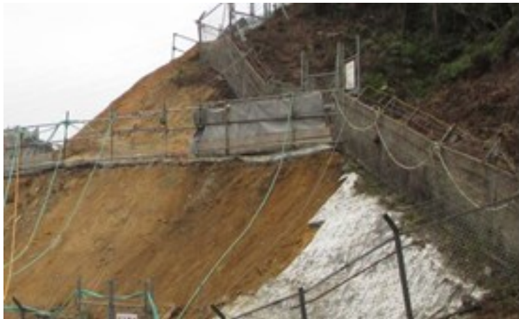
老朽化吹付工のはつり取り作業
