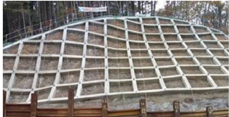
老朽化吹付工撤去後に新設した格子枠工
