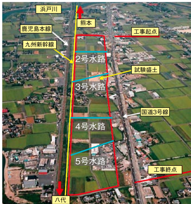
図1 熊本車両基地の全景
