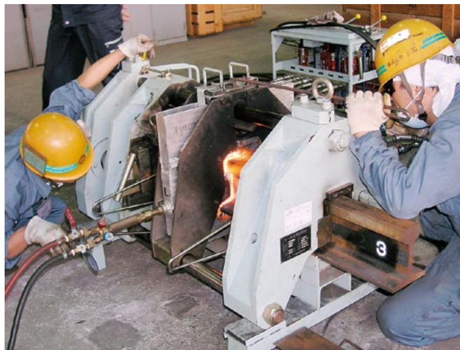
図 水素ガスを用いたレールのガス圧接作業状況
