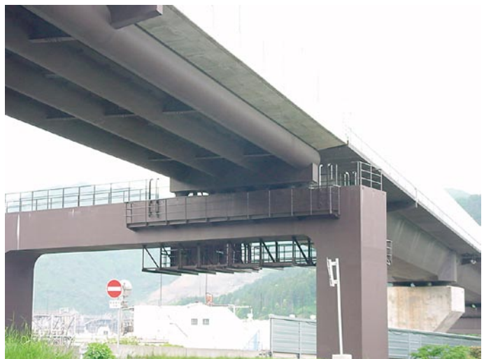
図 世界で初めてNi系高耐候性鋼材を採用した 北陸新幹線 北陸道架道橋
