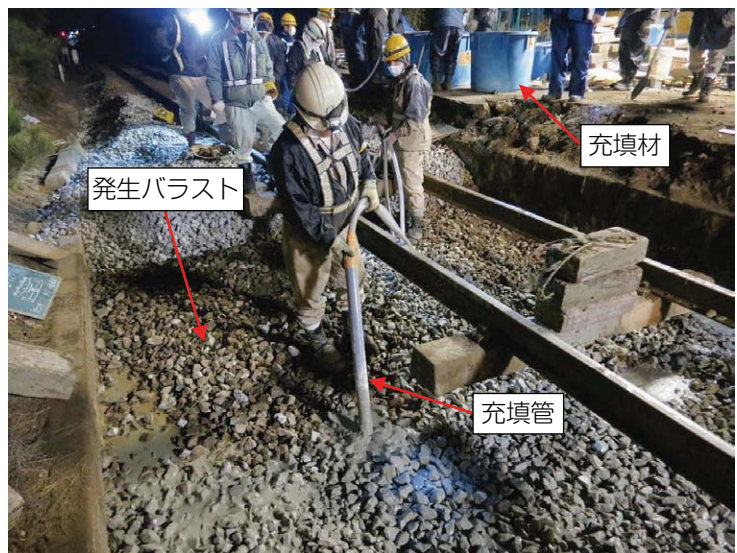
図 新しい路盤改良工法の概要(グラウト充填状況)
