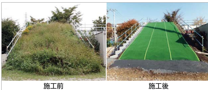
図 防護シート施工状況
