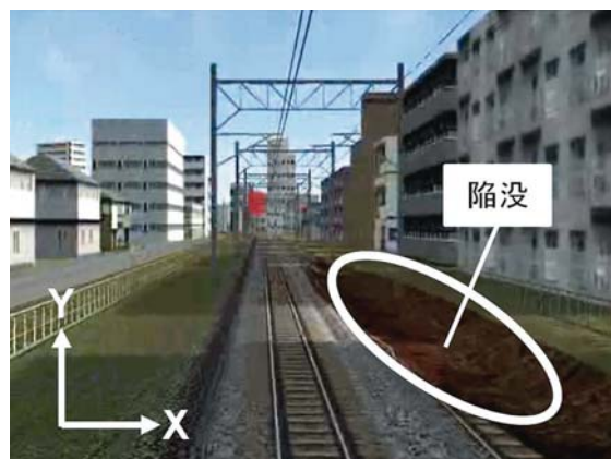
図 異常事象(陥没)の様子<赤印は注視点の例>
