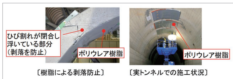
図 模型実験と試験施工によるポリウレア樹脂の性能の確認
