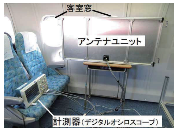
図 展示車両における部分放電検出試験
