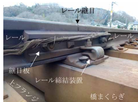
図1 レール継目の構造(支え継ぎ)
