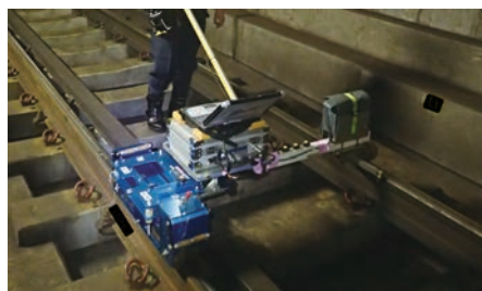
図6 レール凹凸連続測定装置による測定状況
