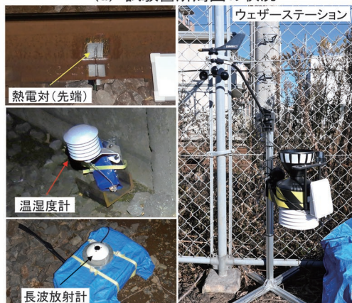
(b) 測定機器の設置状況
