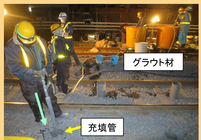
図2 グラウト材の充填状況
