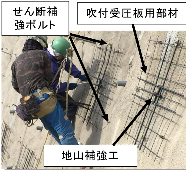
本工法の施工実施状況
