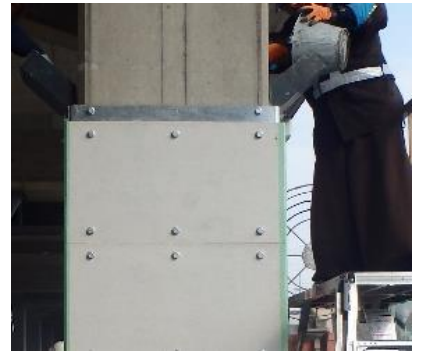
実物大の載荷実験による補強効果の検証
