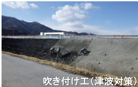
地山補強材打設
