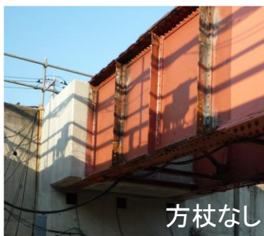
鋼桁と橋台の一体化の例
