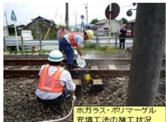
図3-1-9 列車低密度線区の軌道補修法の開発
