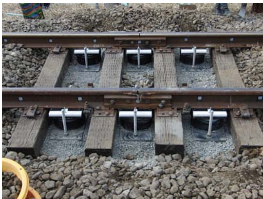
図3-1-11 自動沈下補正まくらぎ-S型
