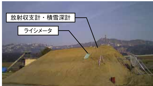
図5-2-3 新設した盛土(無雪期)
