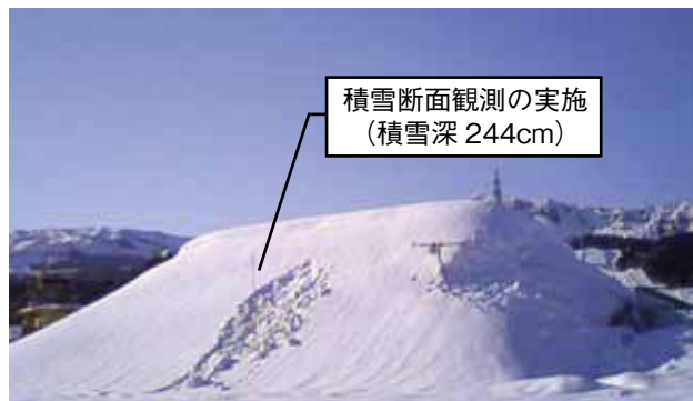
図5-2-4 新設した盛土(積雪期)
