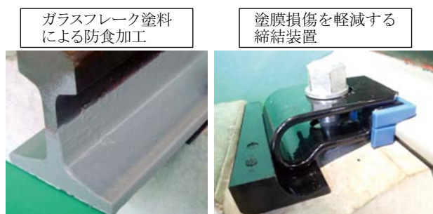
図4-5-1 提案したレールの防食工法
