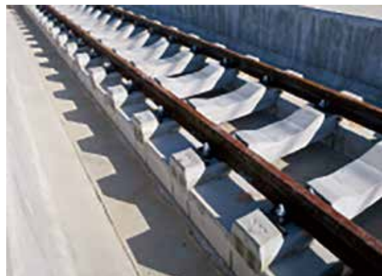
Fig. 3 S-type STR construction site
