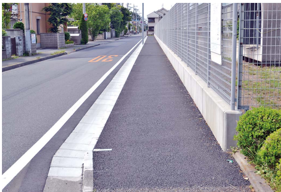
図5-8-9 弁天通りの歩道
