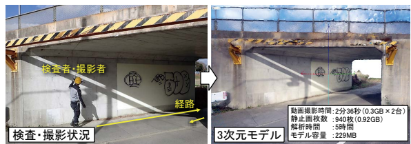
図4-3-2 検査・撮影状況(左)と構造物モデリングの結果(右)
