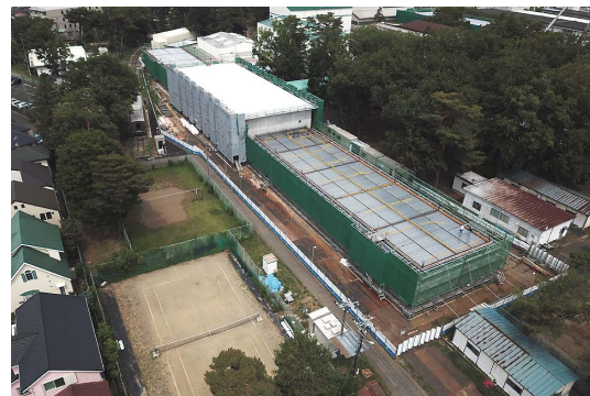
図5-5-4 低騒音列車模型走行試験装置実験棟工事状況
