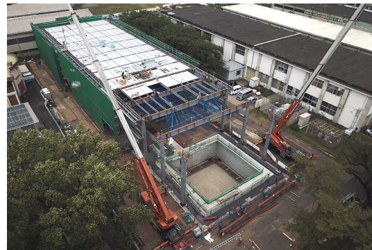
図5-5-3 新実験棟工事状況
