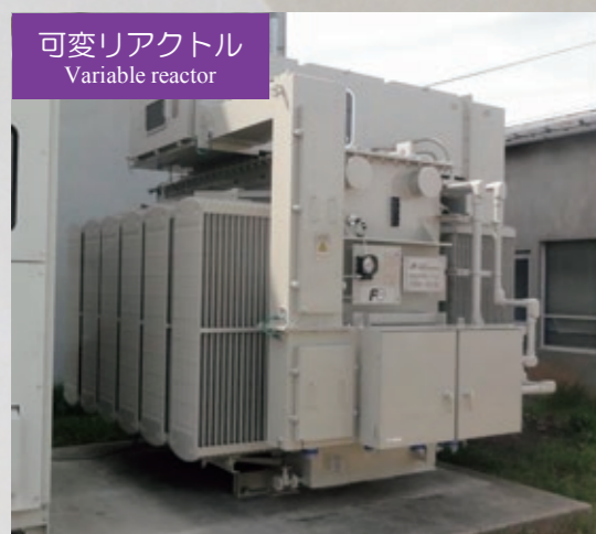
可変リアクトルによる直流き電電圧制御手法 DC-Power-supply voltage control system using variable reactor
