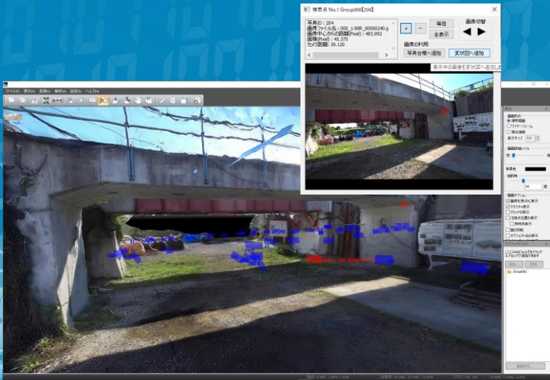
構造物技術研究部 3D画像による目視検査支援システム
