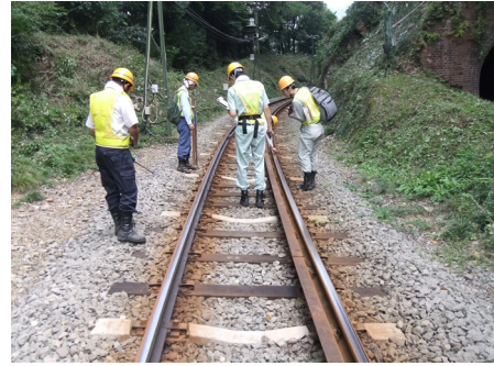
現地調査の様子
