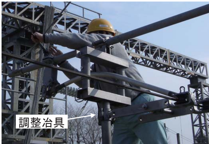
図3 トロリ線調整作業
