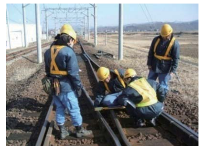
現地調査の状況
