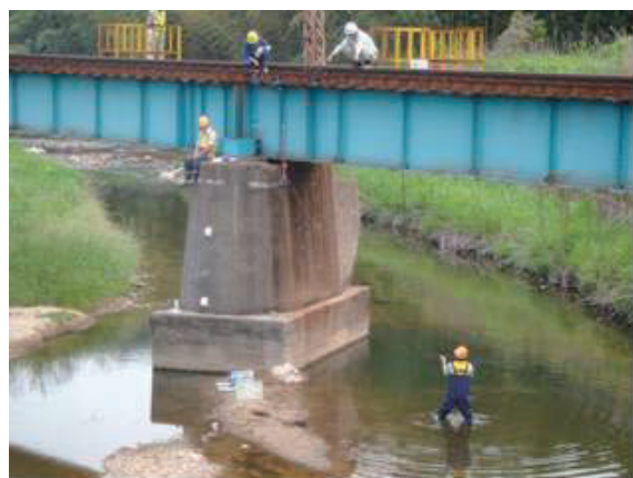
橋脚の健全度診断
