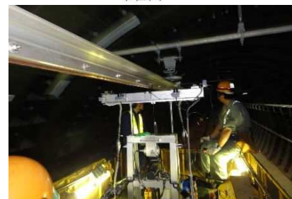
剛体電車線の精密凹凸測定
