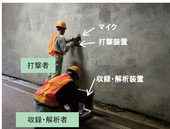
トンネル覆工コンクリートの打音測定状況
