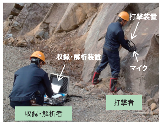
岩盤斜面中の岩塊の打音測定状況
