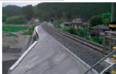
復旧後の盛土
