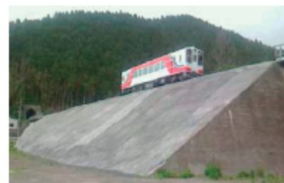
復旧後の盛土（開業後）
