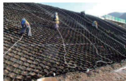
2 ジオセルの敷設
