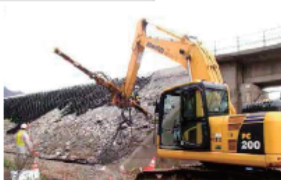
1 地山補強材の打設
