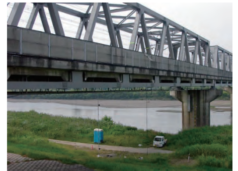
桁の常時・地震時変位 列車通過時の鉛直変位
