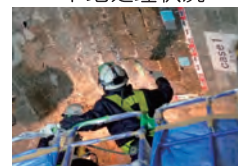
プライマー塗布状況
