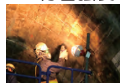
下地処理状況
