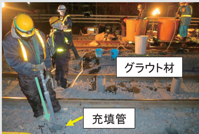
グラウト充填作業の状況
