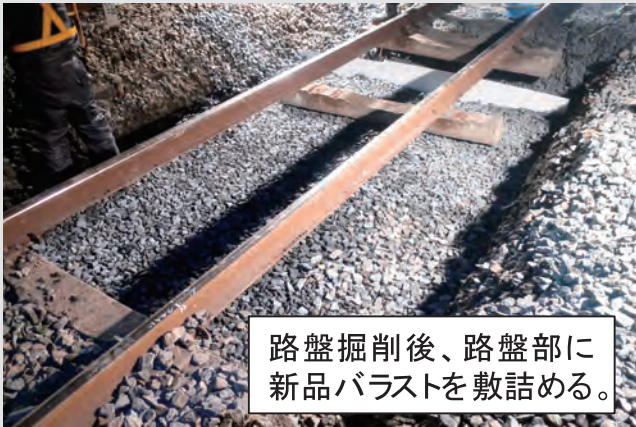
路盤部に新品バラストを敷き詰めた状態
