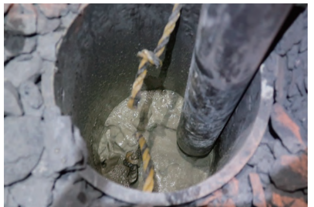
グラウト充填時の充填管内の状況
