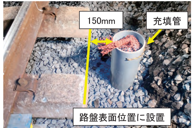
充填管の設置状況
