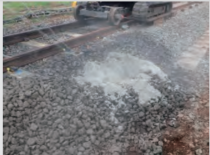
①土砂混入バラストの肩にセメント・水を投入
