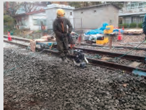
④上面まで締固め
